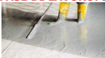
Trattasi della realizzazione di massetti in calcestruzzo semplice o leggermente armato (rete elettrosaldata) per sottofondo di pavimenti (interni ed esterni), formazione di pendenze, ecc.
