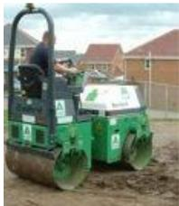
Stabilizzazione del terreno ottenuta con aggiunta di frazione granulometrica in sito e costipamento con rulli.
